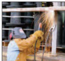
Soldadura de Electrodo Revestido con CD
